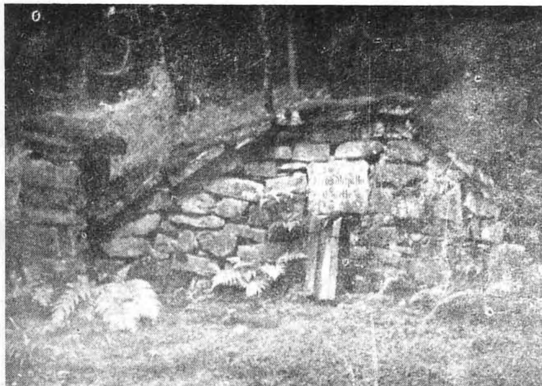
stav v padesátých letech
