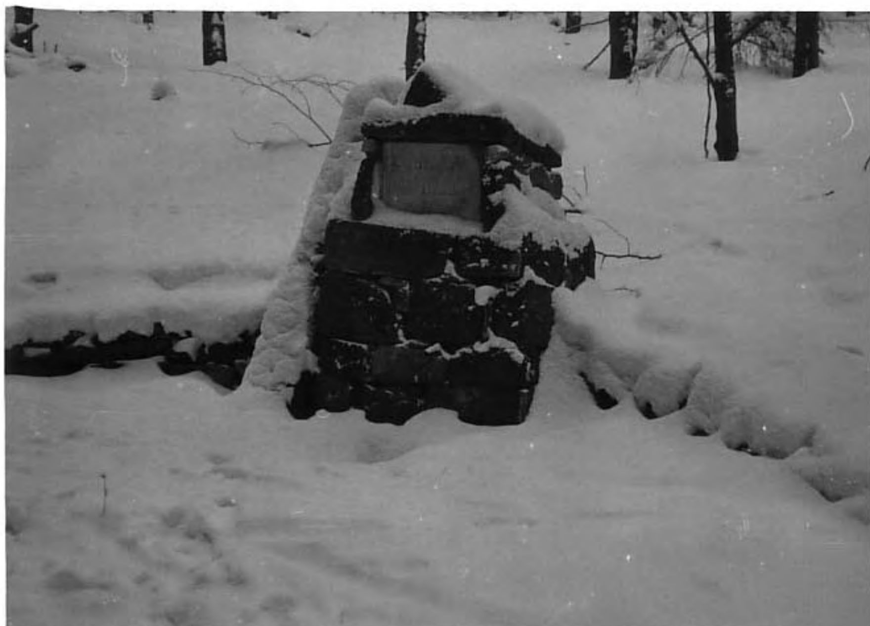
stav těsně po nové obnově
